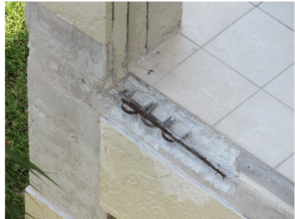
404 deck edge repairs
