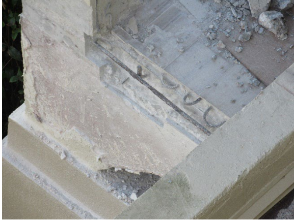
104 deck edge repairs
