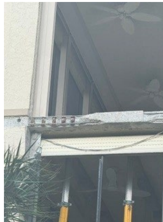
F Bldg. 5 Stack
